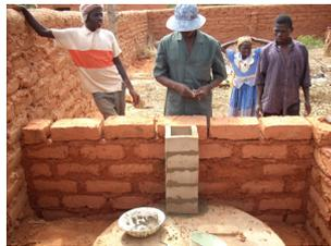
Construction du tuyau de ventilation sur la dalle posée sur la fosse
