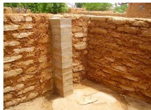
Latrine finie en matériaux locaux, avec trou de défécation toujours fermé et le tuyau permettant la ventilation de l'ouvrage
